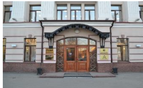
Вход в здание
